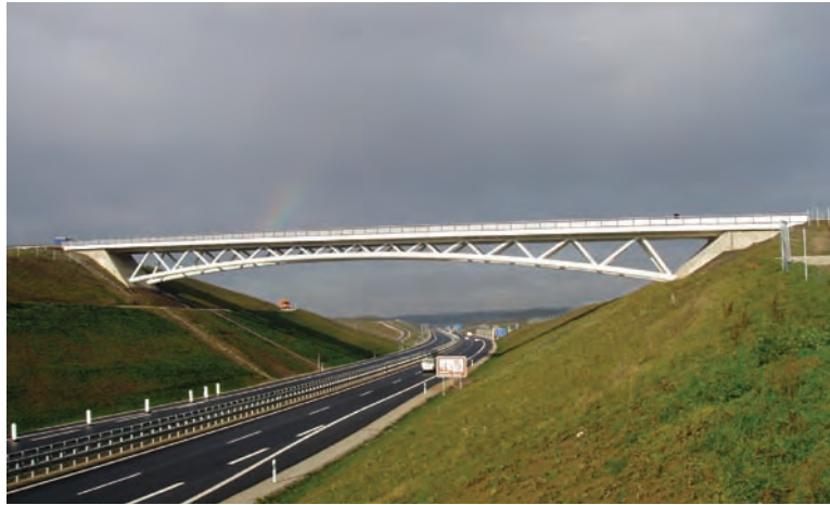
7 Rohrkonstruktion vor der Abnahme © Autobahndirektion Nordbayern
